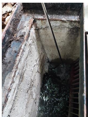
รูปที่ 3.33 ภาพแสดงการเก็บตัวอย่างน้ำจุดที่ 5 คุณภาพน้ำก่อนระบายออกสู่ภายนอกโครงการ บ่อดักขยะ
